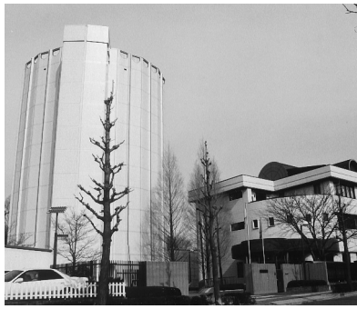
▲第一配水塔（水道事務所）
