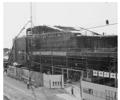
▲順調に工事が進む生涯学習施設(仮称)西棟
