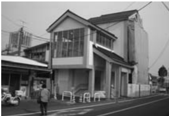
▲羽村駅西口駅舎工事
