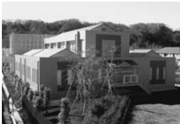
▲羽村市浄水場(羽中四丁目付近)
