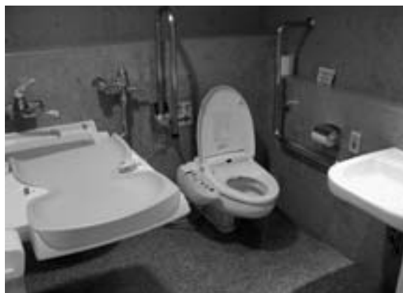
▲様々な機能を備えたトイレ（生涯学習センターゆとろぎ）
