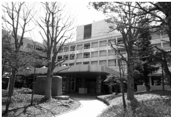
▲羽村市役所庁舎
