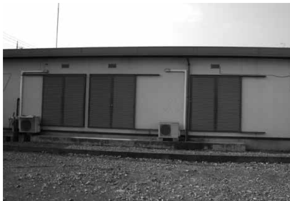
▲羽村市第2被災者一時宿泊所
