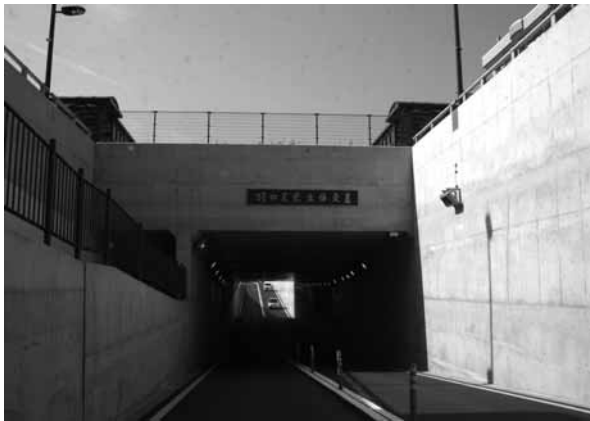
▲羽加美栄立体交差
