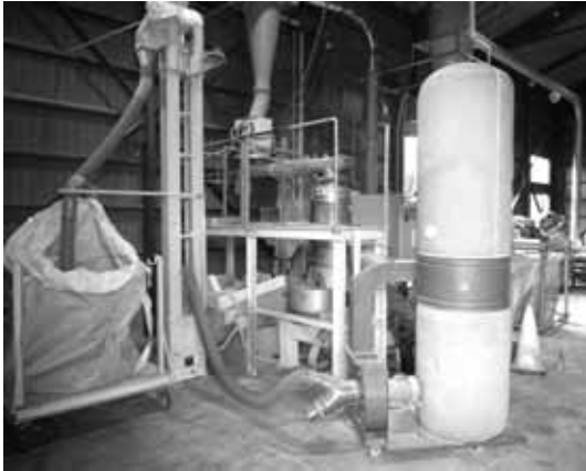
▲ペレット製造装置
