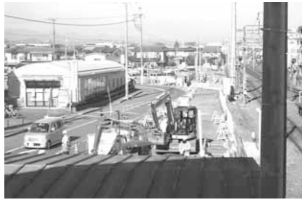
▲工事中の羽村駅西口
