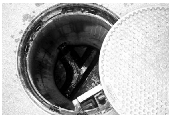
▲スリップ防止のロック式マンホール蓋と内部
