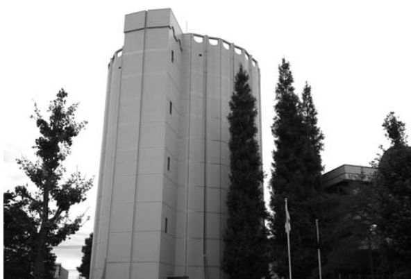
▲水道事務所横にそびえ立つ配水塔
