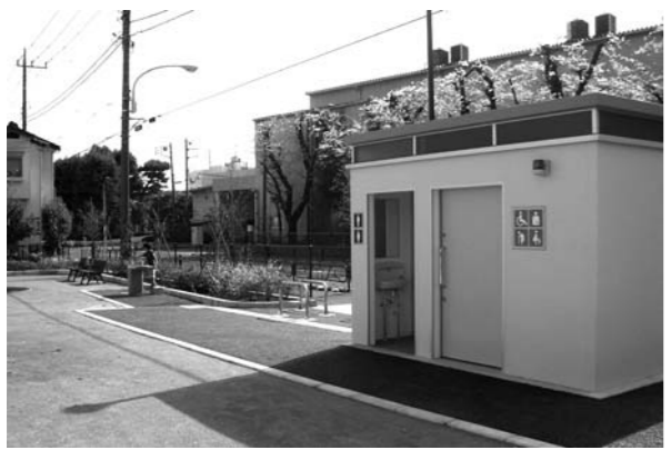
▲(仮称)双葉町公園の「だれでもトイレ」
