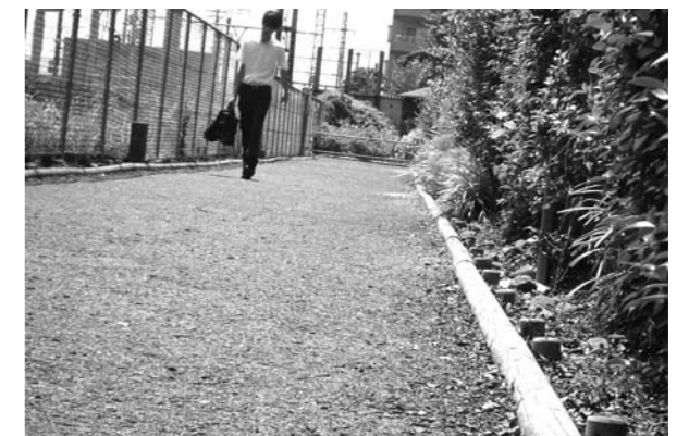
▲羽村駅西口 線路沿いのウッドチップ舗装された歩道
