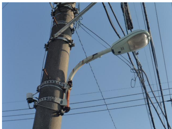
老朽化した小型水銀灯(区画街路・生活道路)
