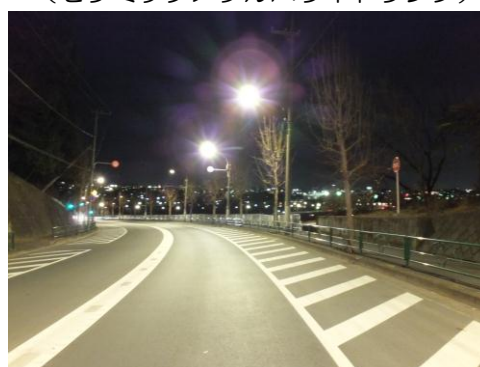
(2) 大型道路照明の例 （セラミックメタルハライドランプ）
