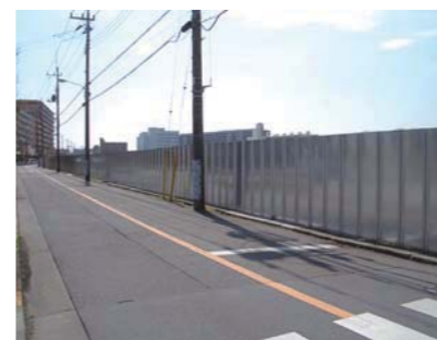
イオンタウン建設予定地北側
