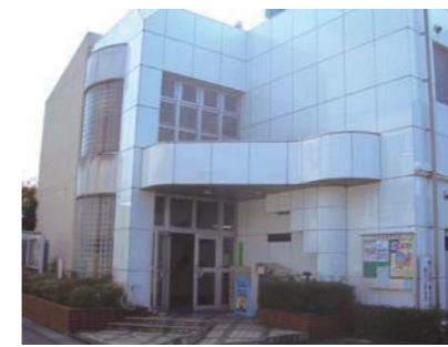
小作台西会館
