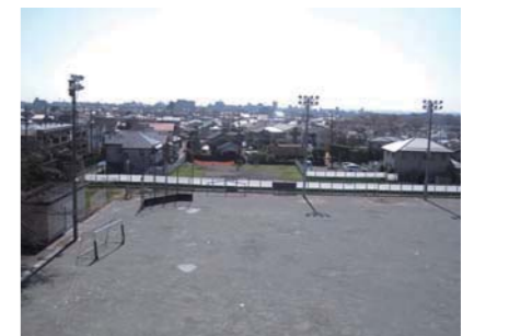
工事中の羽村東小学校校庭
