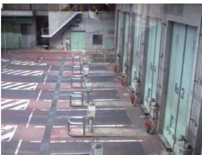
西多摩衛生組合内 プラットホーム
