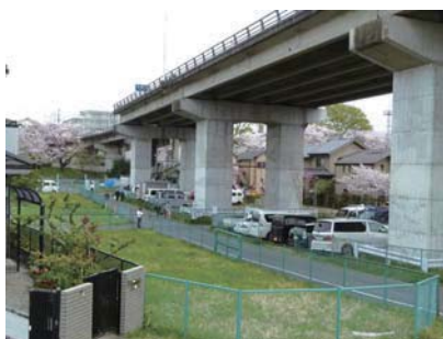
羽村大橋拡幅工事予定地
