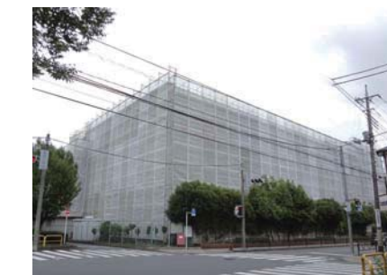
改修工事中の羽村第二中学校体育館
