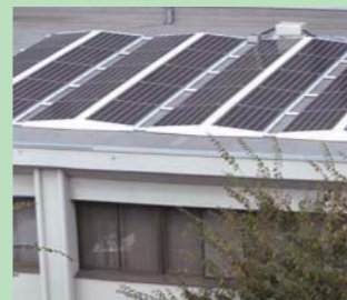
市役所西分室屋上の太陽光パネル
