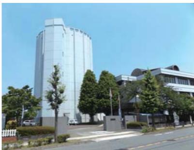
水道事務所と配水塔
