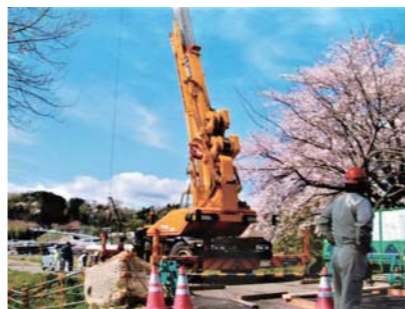
警察の厳重注意を受けた工事現場
