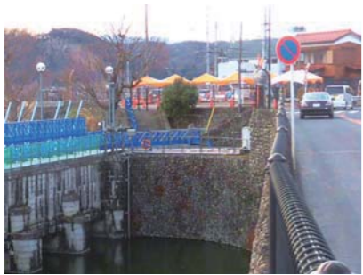
羽村堰上の角地に設置された模擬店・休憩所
