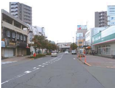
無電柱化した小作駅東口
