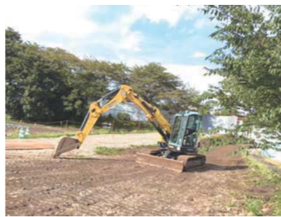
羽村大橋周辺の工事現場
