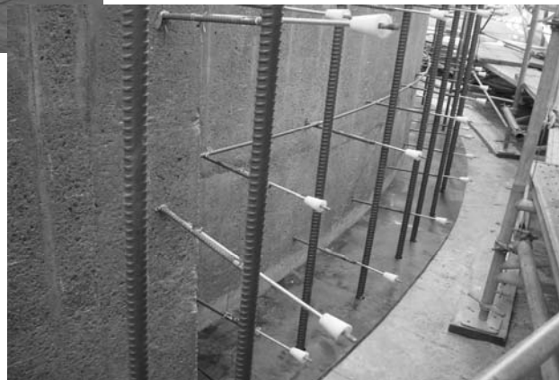
【第 2 配水場高区配水塔耐震補強工事】
