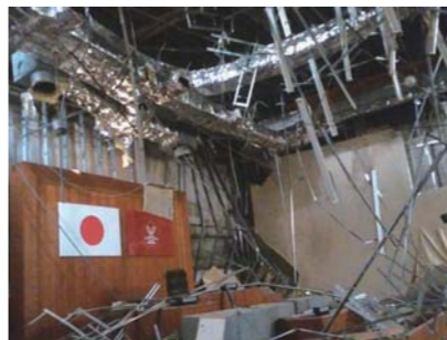
被災した益城町役場の議場
