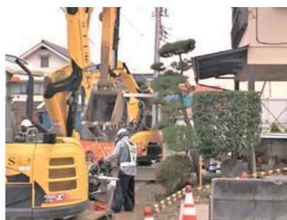
住居の間際まで迫る工事
