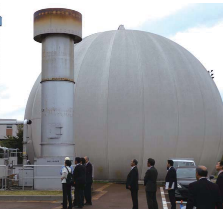
▲生ごみバイオガス発電センターのガスホルダー
