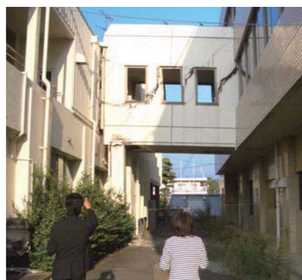
▲益城町役場の渡り廊下。大きな亀裂が入り使用できない
