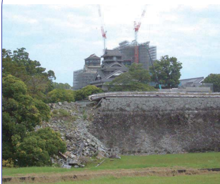
▲地震で石垣も大きく崩れた熊本城
