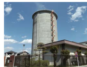
監視カメラが新たに設置される第2配水場
