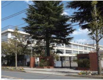
32年度でトイレ改修工事が完了する富士見小学校
