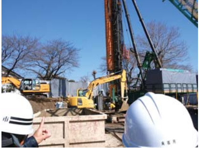
都市計画道路3・4・12号線の擁壁工事現場
