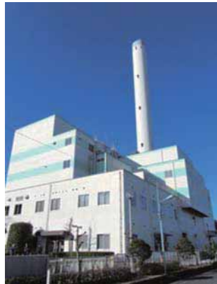
31年度末で稼働が終了する昭島市清掃センター
