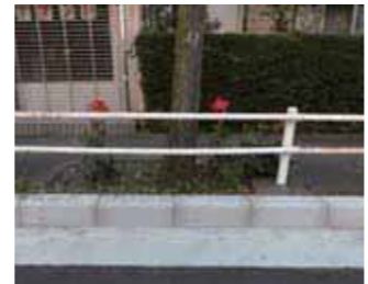
▲イチョウの根の盛り上がり
