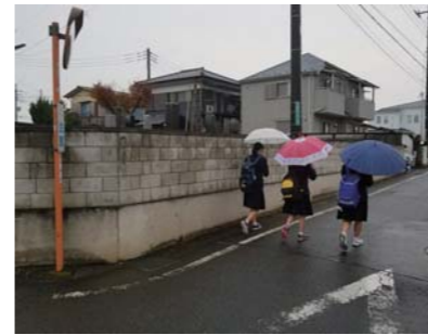
通学路沿いの古いブロック塀
