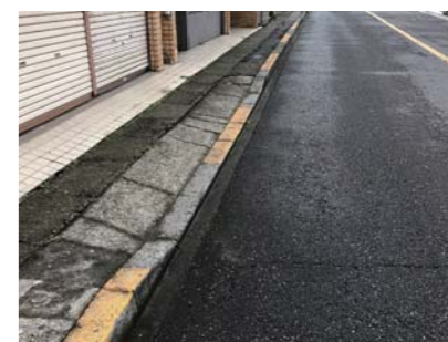
段差があり、幅も狭い歩道
