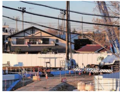
住宅前で、騒音・振動工事が続く
