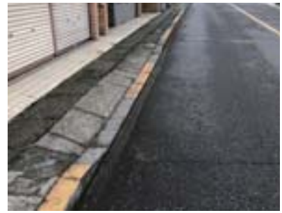
段差があり、幅も狭い歩道
