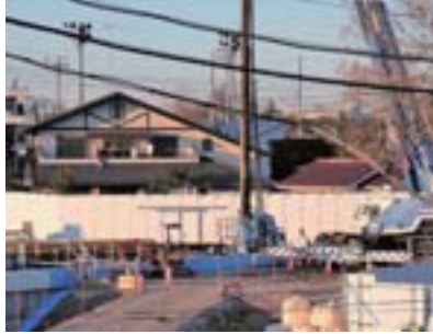
住宅前で、騒音・振動工事が続く
