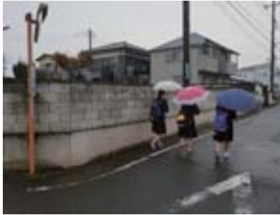
通学路沿いの古いブロック塀
