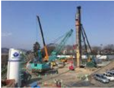
都市計画道路3・4・12号線の擁壁工事
