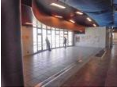
羽村駅自由通路拡幅現況
