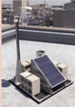
▲庁舎屋上に設置した気象観測装置
