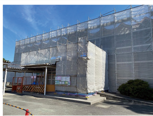
▲工事中の体育館
