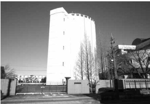
▲第1配水場（水道事務所）
