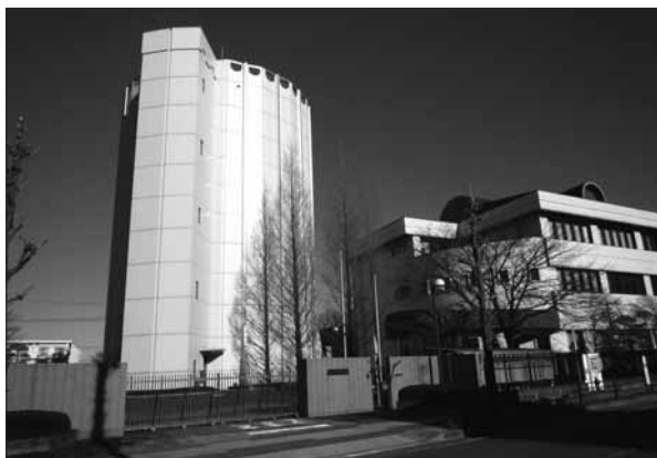
▲羽村市水道事務所
