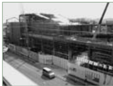
▲生涯学習施設(仮称)西棟の建設が進んでいます。
