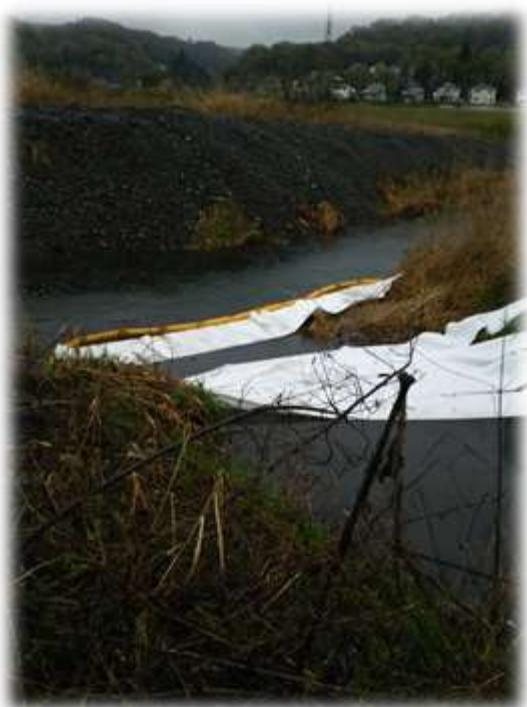
多摩川に接続している雨水管から流出する油を防ぎ、除去している様子。(右)
