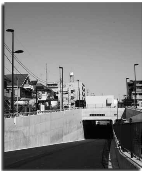
▲羽加美栄立体交差まもなく開催 （撮影：3月2日（月）羽加美側から）
