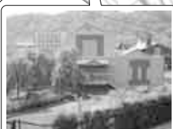
▲浄水場内膜ろ過施設
