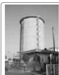
▲第2配水場管理棟および高区配水塔
