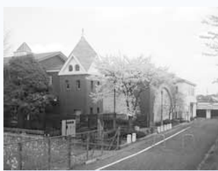
▲浄水場管理棟
