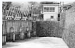
▲羽村堰取水口
