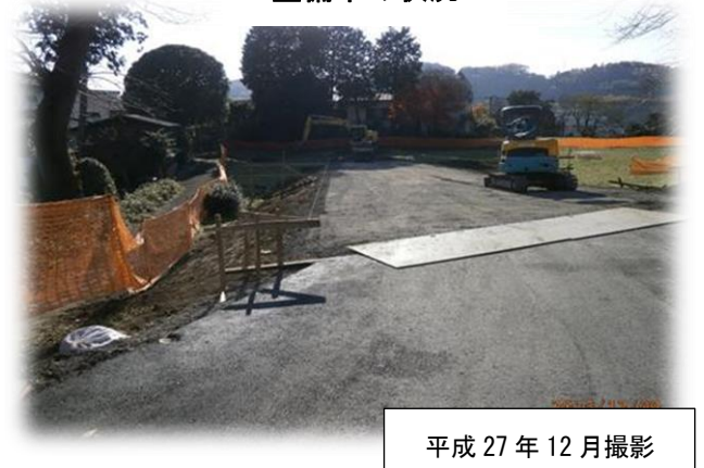
整備中の状況
