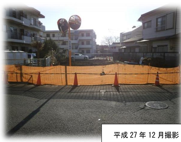
整備中の状況
