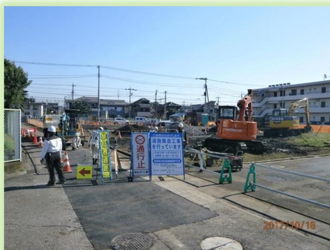
② 道路拡幅工事の状況
