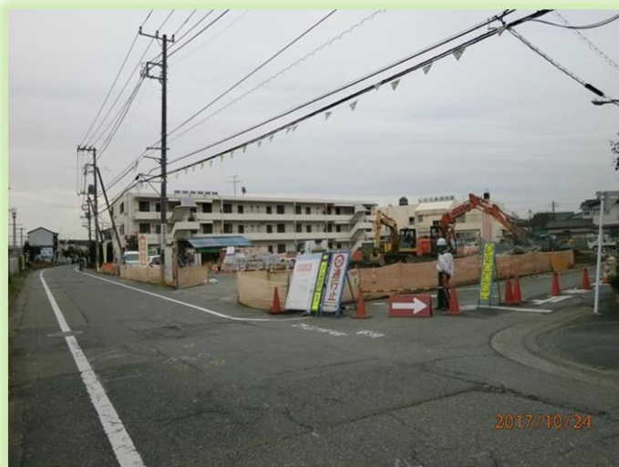
① 道路拡幅工事の状況
