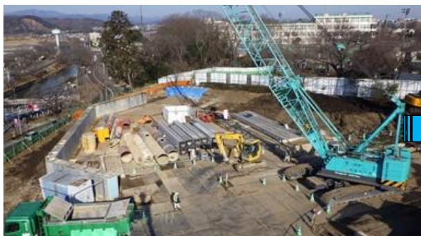
【平成 29 年度 擁壁設置工事中の状況】（上図①）
