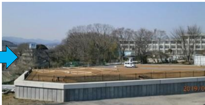
【平成 30 年度 宅地造成後の状況】（上図①）
