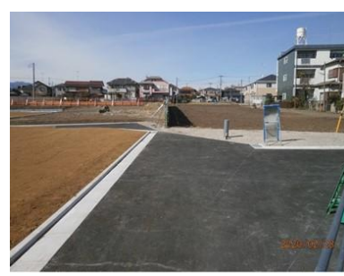
【工事着手前】(上図 ④)
