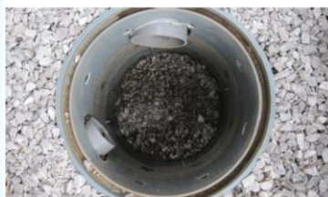
雨水浸透ます
