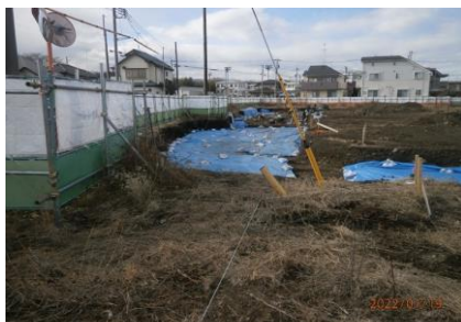
【整備前の状況】 (左図 ⑤)
