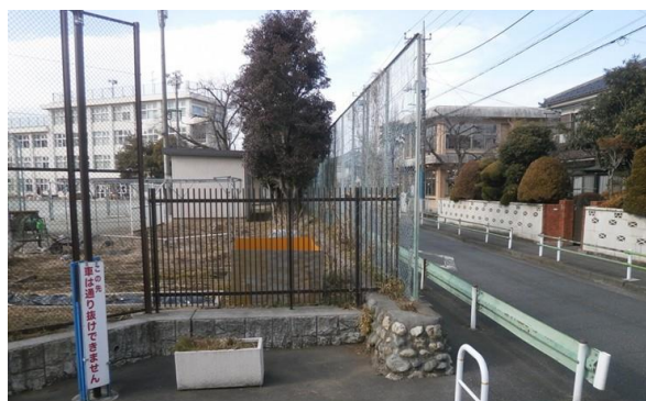
【整備前の状況】 (左図 ⑦)
