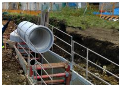
( 雨水管設置工事状況 )
