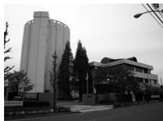
①水道事務所と配水塔
