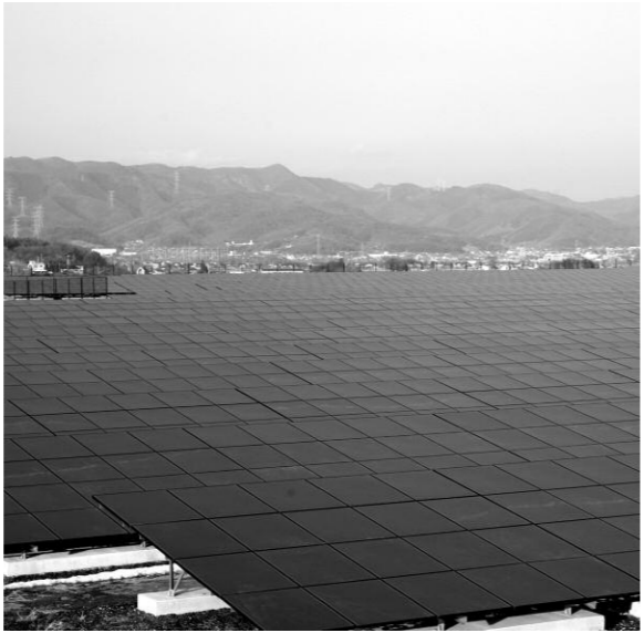
▲広大な面積のおおた太陽光発電所の太陽光パネル
